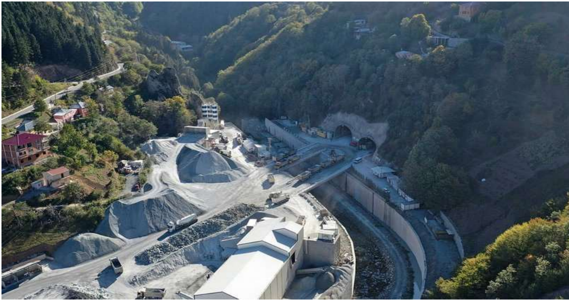
Şekil 5. Dere kenarına depolanmış kırılmış beton malzemesi (URL3).
