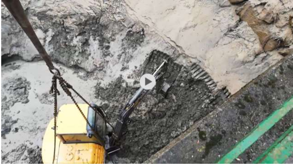
Şekil 3. Mavi Regülatörü rezervuarından silt boşaltma işlemi.
