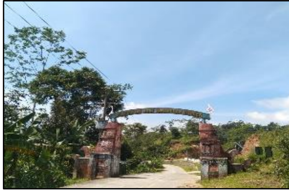
Gambar 2. 3 Pintu Masuk Adat Kasepuhan Citorek (Sumber: Dokumentasi Pribadi)
